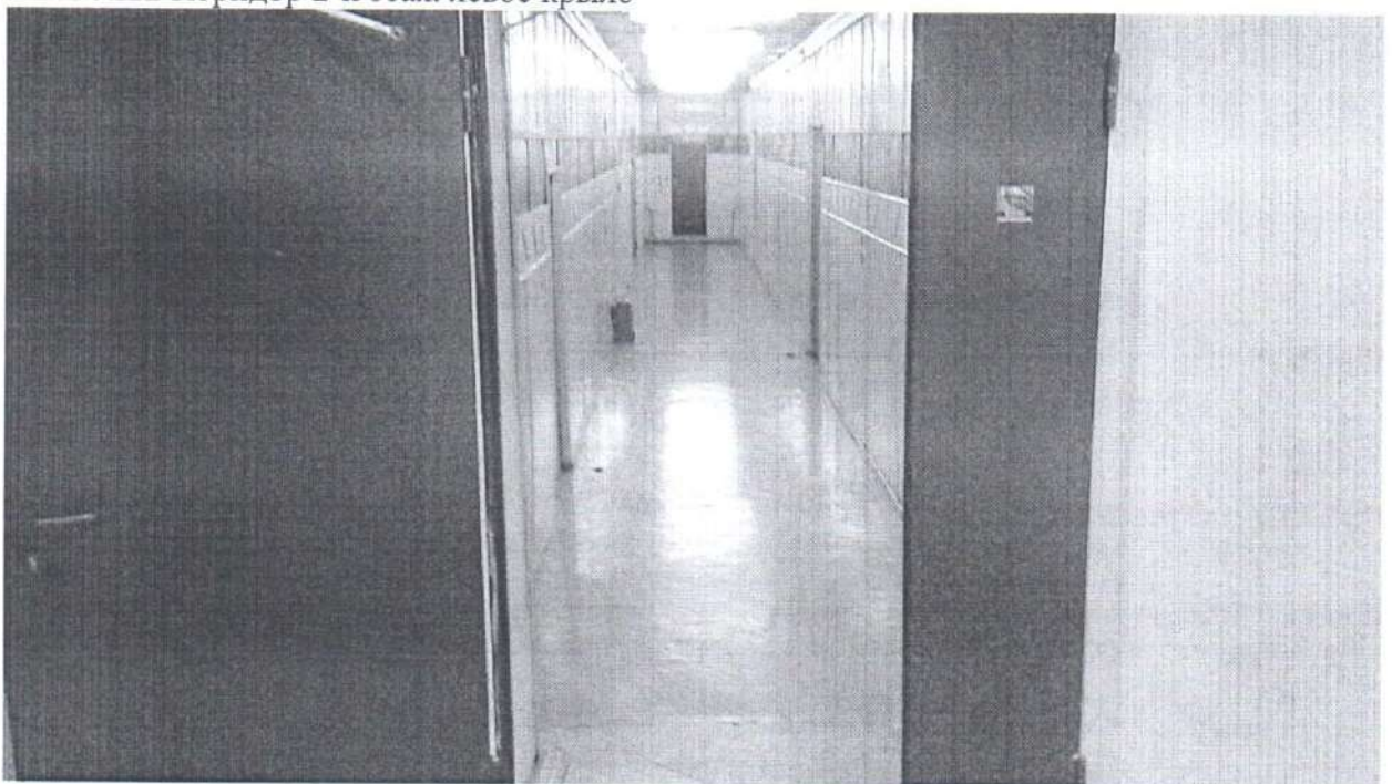
Фото №22 Коридор 2-й этаж левое крыло
